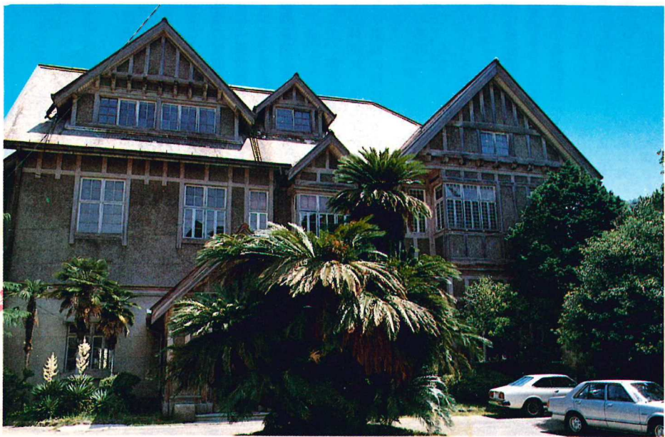
木造二階建て天然スレート葺き、外壁のハーフ・チンパリの木組みは太くダイナミックな構成で、正面に大小五つの切妻屋根が並んだ堂々たる建物である。 アインシュタイン夫妻が来日するときここに泊った。
